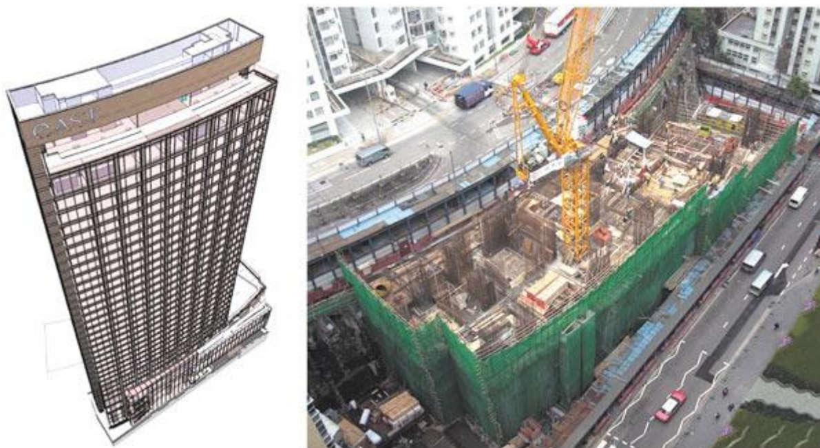
Рис. 3. Архитектурный облик и начало строительства отеля «Восток» в Гонконге. Граница стройплощадки почти полностью совпадает с периметром основания здания (при участии фирмы Gehry Technologies, 2004)
