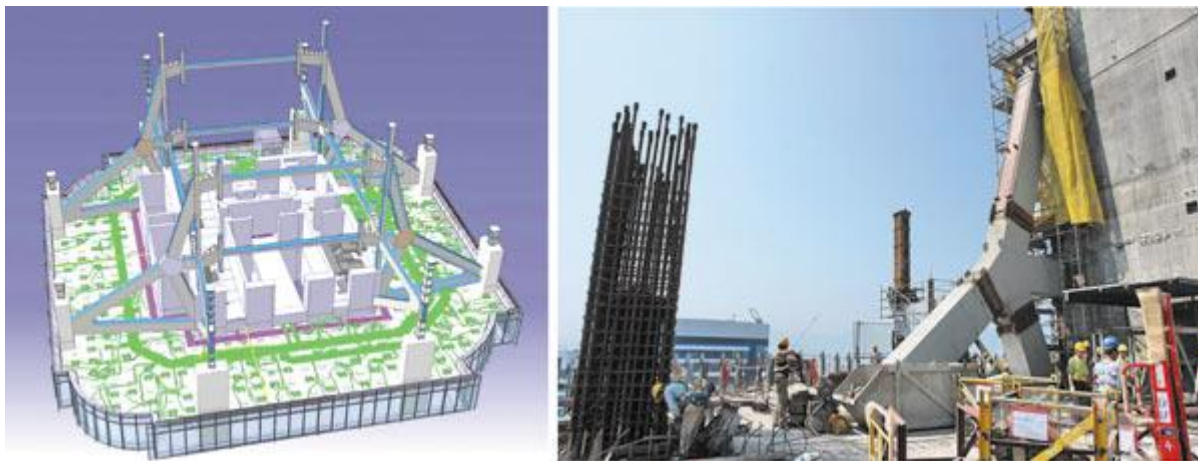
Рис. 5. Строительство небоскреба «Восточная башня» в Гонконге. Возведение здания по компьютерной модели (при участии фирмы Gehry Technologies, 2005)
