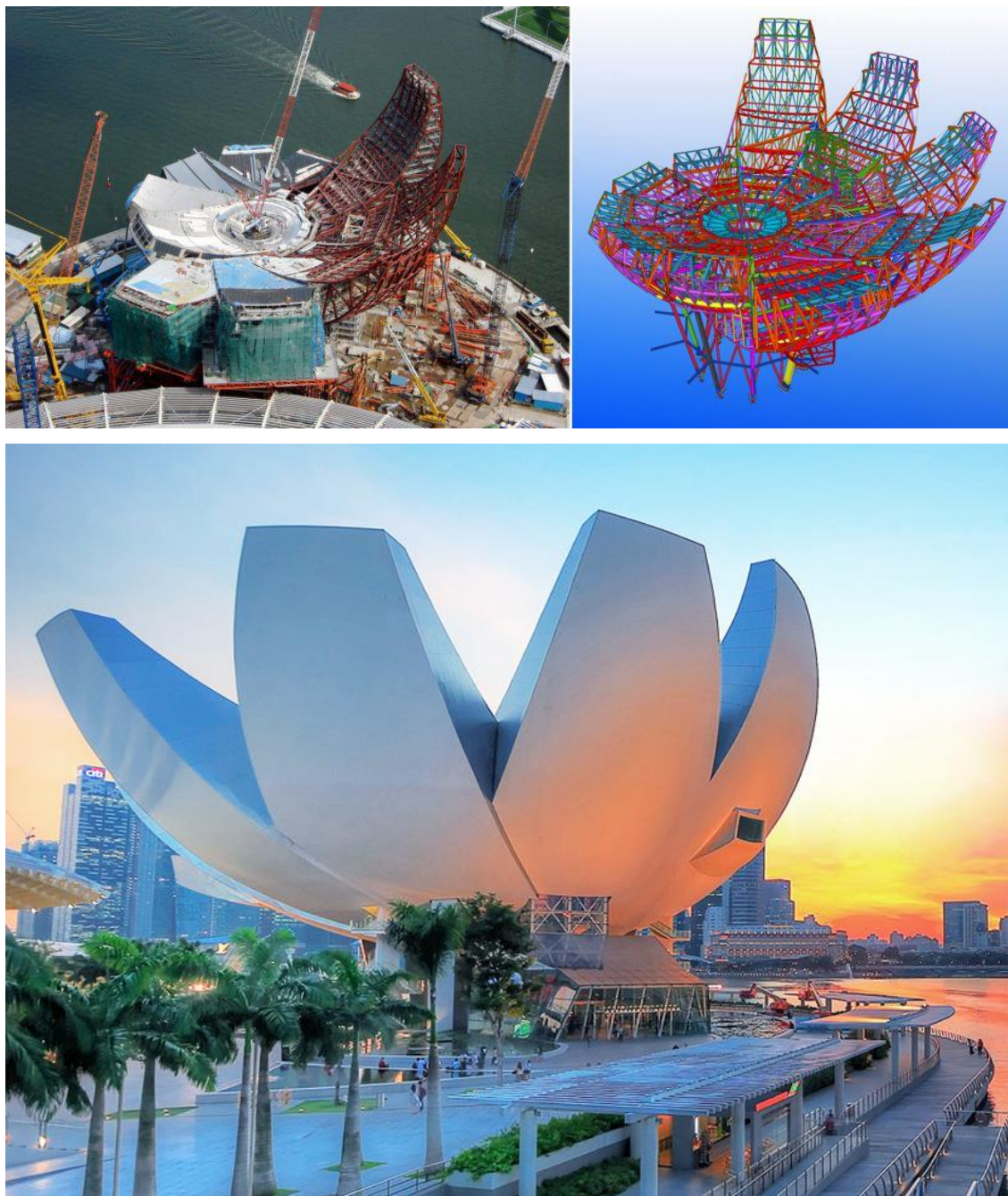
Рис. 10. Здание Музея науки и искусства – одна из «визитных карточек» использования BIM в Сингапуре. Слева: здание в период строительства, справа – модель стального каркаса музея, выполненная в программе Tekla Structure.
